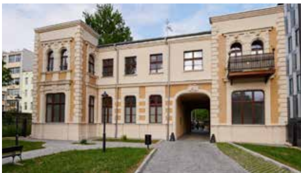
Figure 1.1.11 Poland | MULTIGENERATIONAL HOUSE IN LODZ / DOM WIELOPOKOLENIOWY W ŁODZI, CITY OF LODZ / MIASTO ŁÓDŹ
